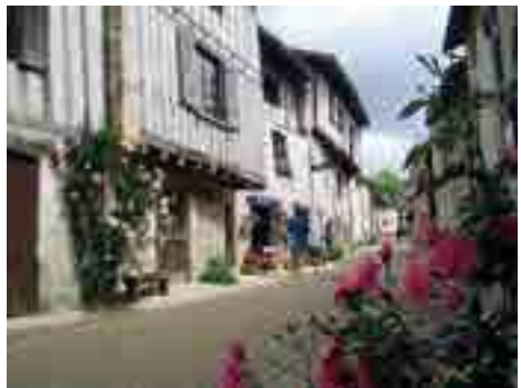
Maisons à colombages à Saint-Jean-de-Côle
