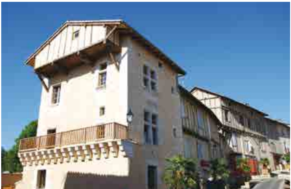
Saint-Astier, maison sur rempart
